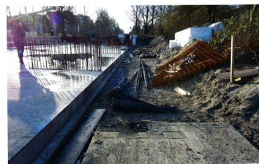
Foto 4 Toegepast scherm naast fundering
