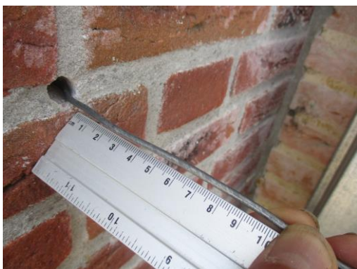
Figuur 2 De gevel is voorzien van 100 mm isolatie.
