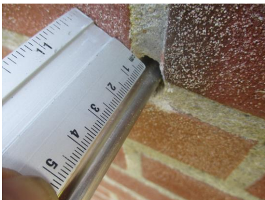
Figuur 2 De gevel is deels voorzien van 50 mm isolatie.
